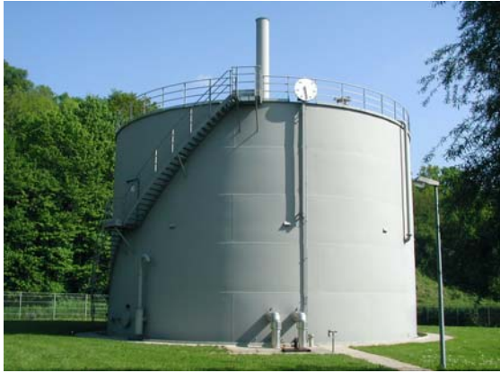
Biogasbehälter mit geschweißtem Stahlblechgehäuse
