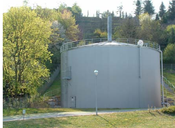
Biogasbehälter mit Tragkonstruktion aus Stahlprofilen und Profilblechverkleidung
