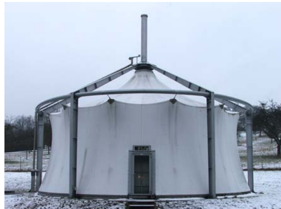
Biogasbehälter mit in der Erde versenktem Betonunterteil und aufgespannter Schutzhülle
