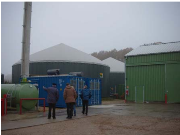
Landwirtschaftlicher Biogasbehälter mit Druckluftpolster
