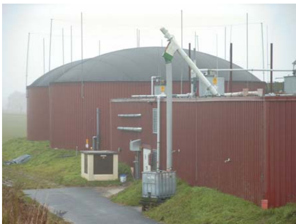
Landwirtschaftlicher Biogasbehälter mit elastischer Membran
